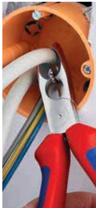
Abmanteln tief unten in der Unterputzdose
