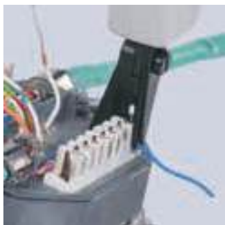
Einlegen und Schneiden von Kabeln in einem Arbeitsgang
